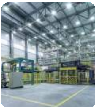
VAPOR DE MERCURIO
